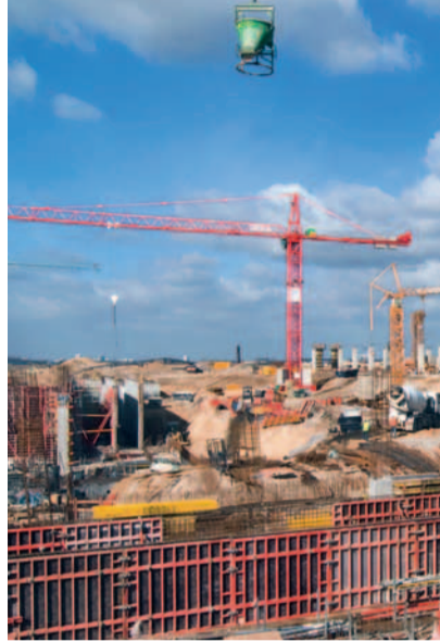
Die größte Flughafenbaustelle Europas hat große Strahlkraft auf die Logistik.
